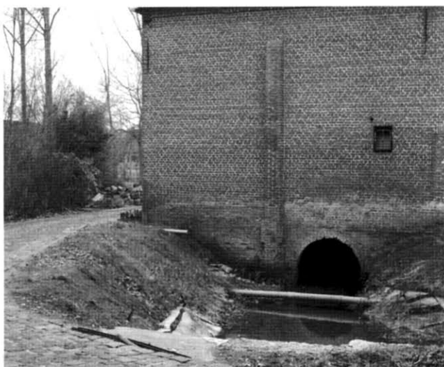
Nedermolen: er stroomt weer water door de tunnel onder het voorgebouw. De spaarvijver wordt regelmatig gevuld en leeg-gemaakt om het geheel open te houden. Foto: F.B.
